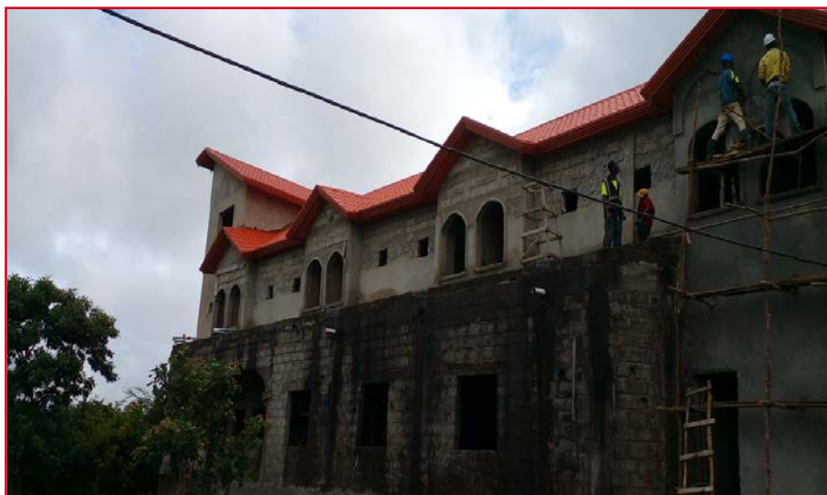
Illustration 1: L'état du bâtiment avant le redémarrage.
